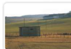
Réalisation de l'étude de Bassin d'Alimentation de Captage à Dye (89)
