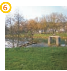
Problématique de continuité écologique sur les ouvrages
